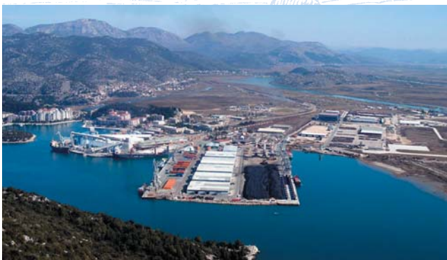
Luka Ploče, buduće veliko gradilište kontejnerskog terminala i terminala za rasute terete
